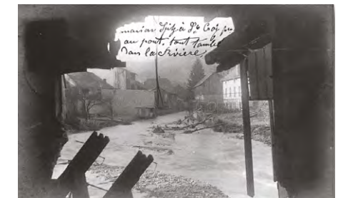
Inondations du 24 décembre 1919 à Sainte-Croix-aux-Mines.
